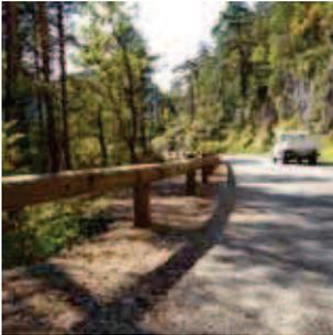
Rondin diamètre 18 cm, longueur 4.00 m, renforcé d'un fer en U sur face arrière.
